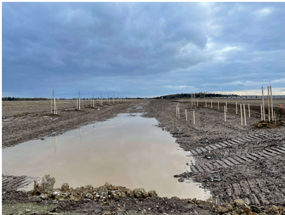
Pohled na nově vybudovaný průleh v Klenovicích. Foto: archiv
